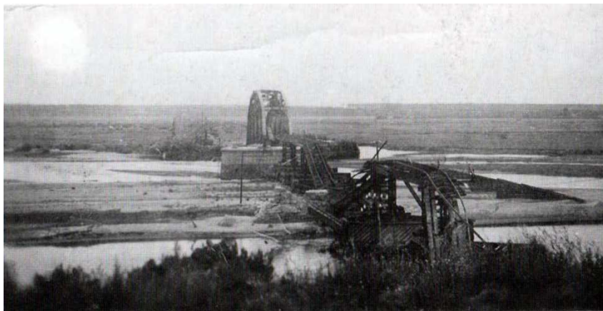
14. Zniszczony most na rzece Pilicy, 1945
